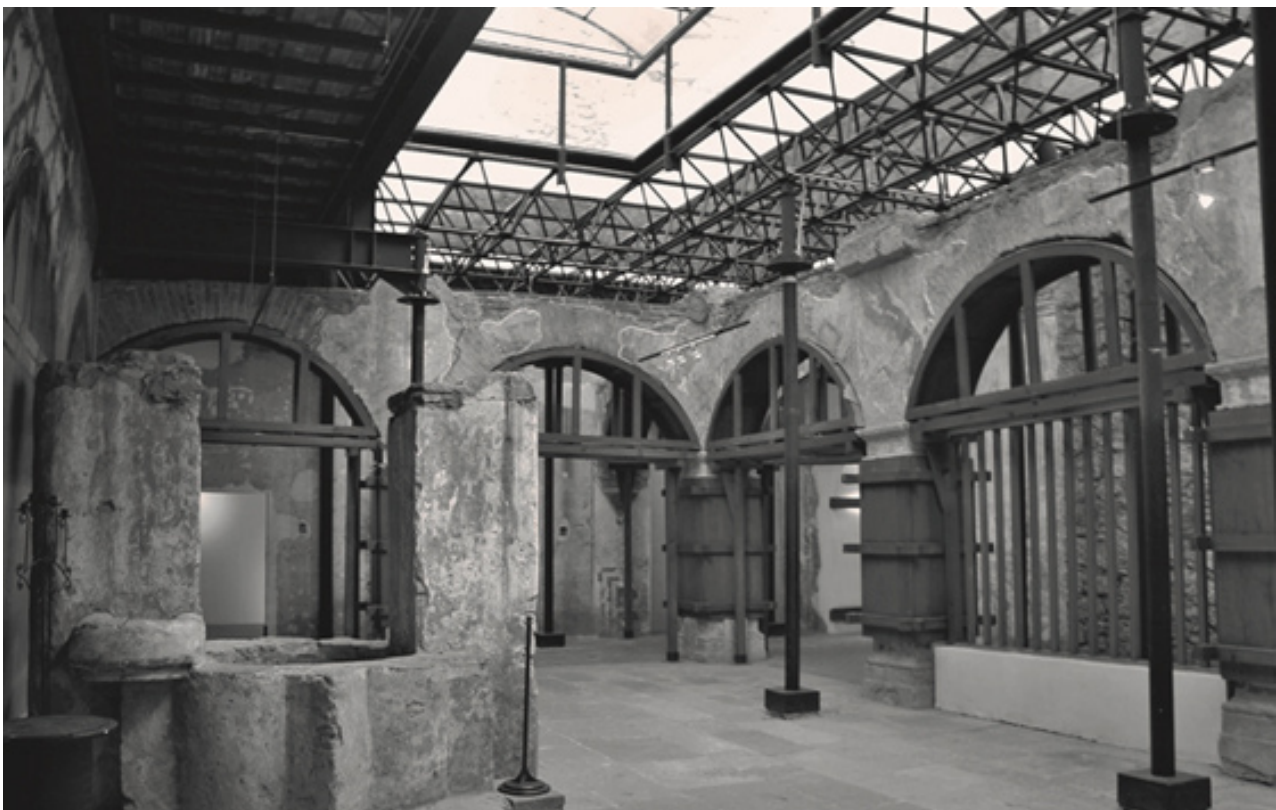
IMAGEN 3: INTERIOR DEL MUSEO DIEGUINO CON EVIDENCIAS DEL CAMBIO DE NIVEL
